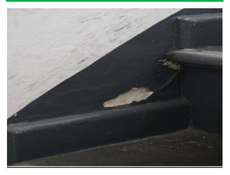
Figure # 18 : DAMAGE TO WALL PLASTER ALONG STAIR TREAD.
